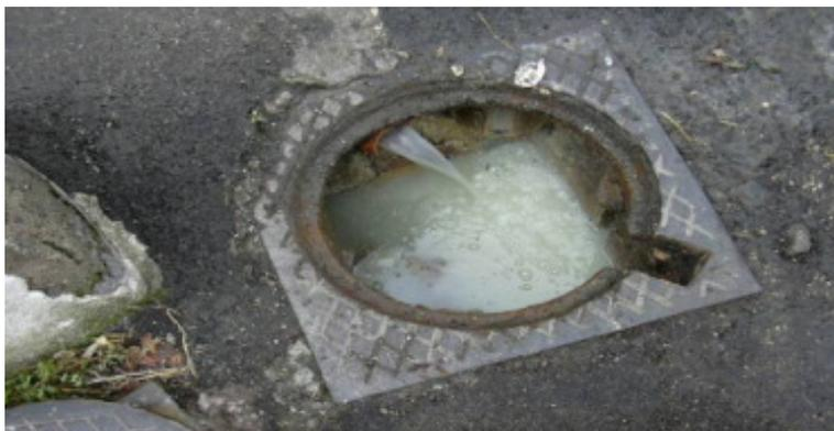
Figura 1 – Scarico non conforme in fognatura (presenza di siero di latte proveniente da attività casearie)
