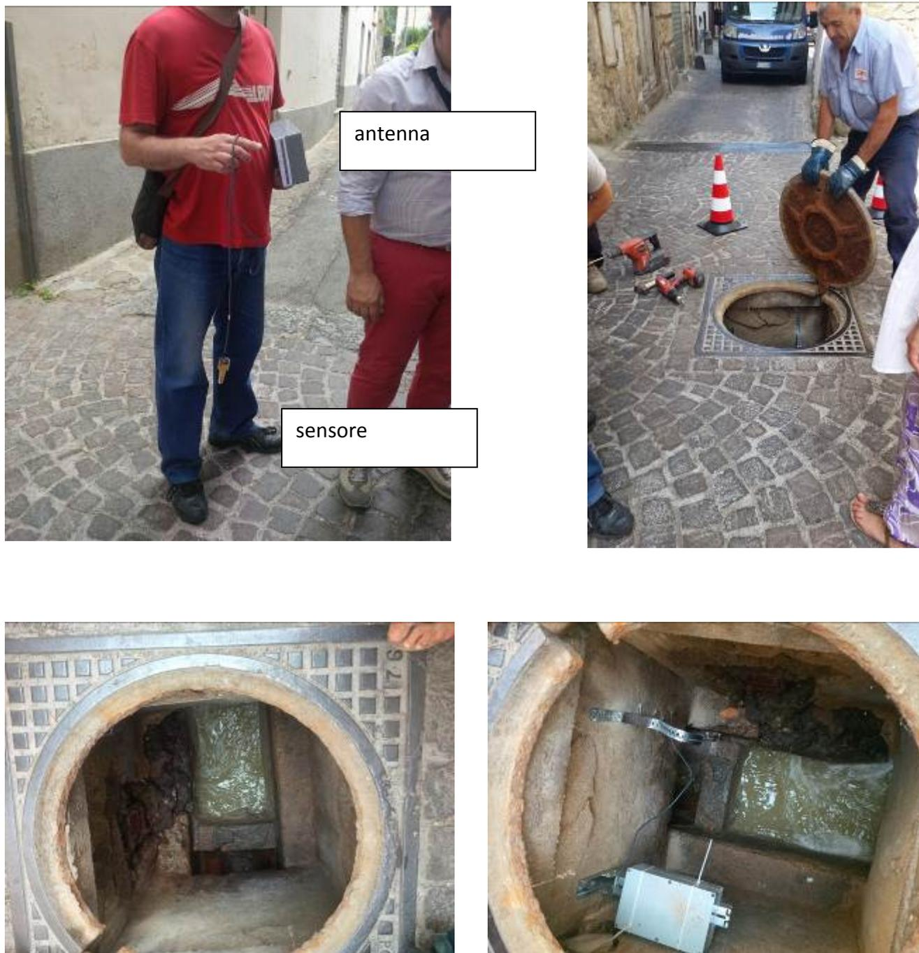
Figura 13 – Installazione sensore prototipale presenza/assenza PPA2
