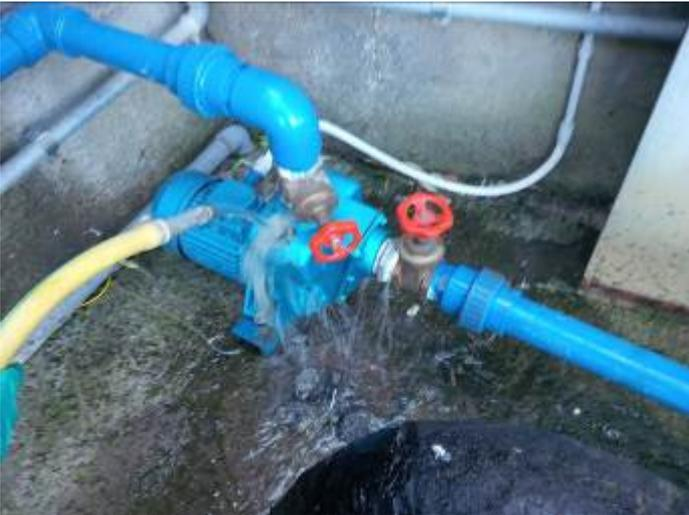
**Figura 3 - Foto posa in opera pompa sommersa in sostituzione di pompa orizzontale a girante arretrata**
